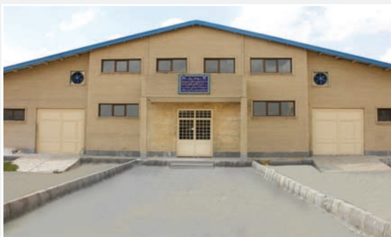
سوله کارگاهی مرکز کرمانشاه
